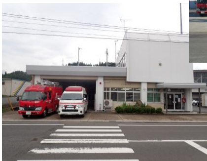
朝日分署庁舎
