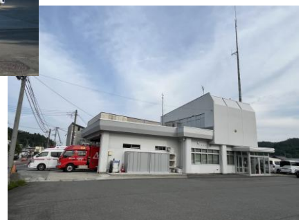
西川分署庁舎
