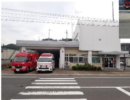
朝日分署庁舎
