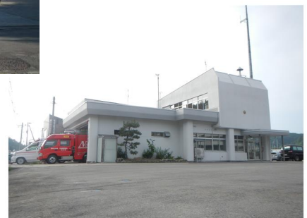
西川分署庁舎
